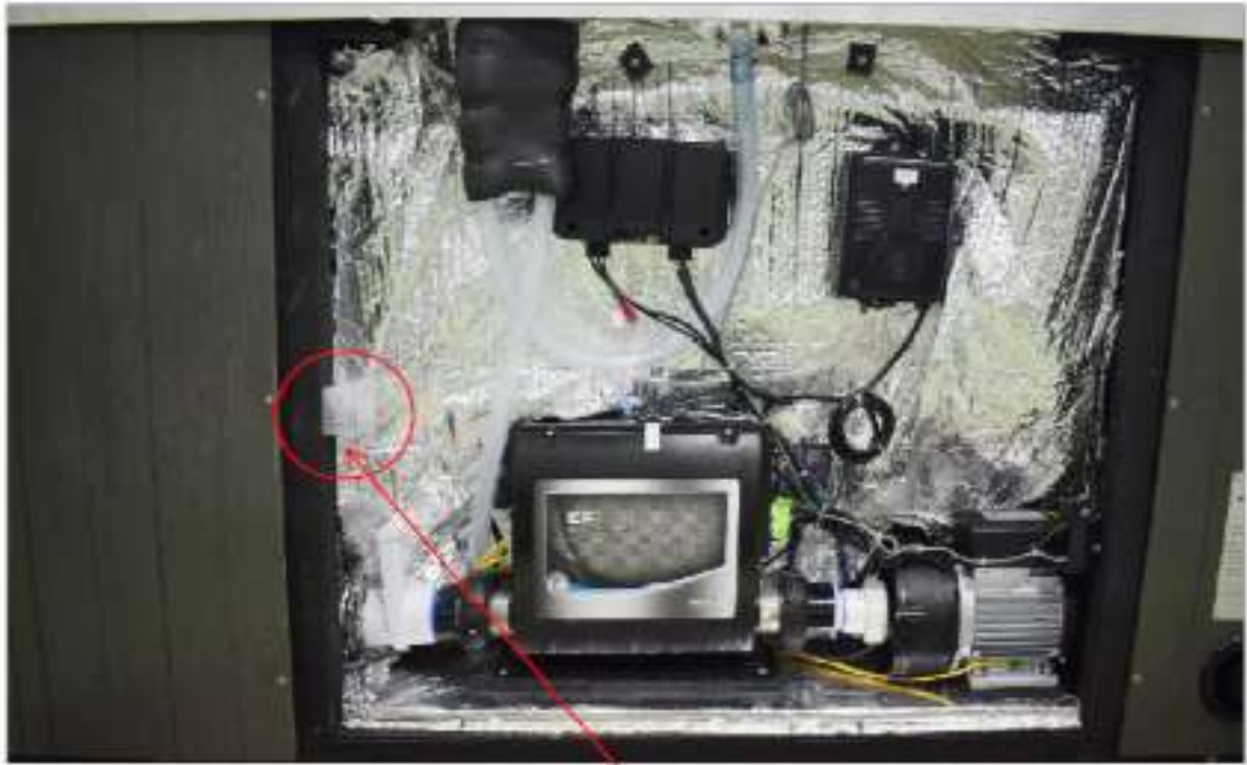
Расположение дополнительного предохранителя
